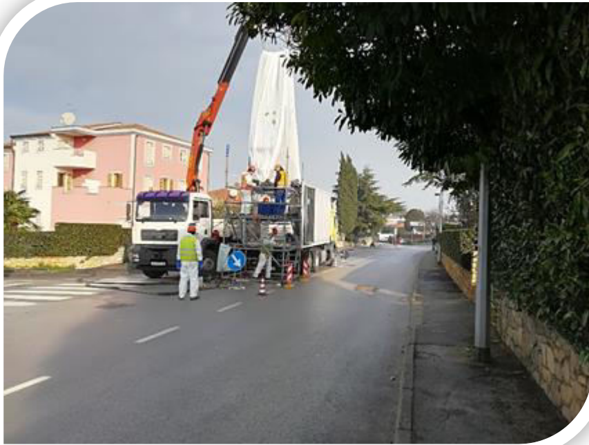
Procedimento di installazione del liner CIPP DN1000 mm in strada con traffico intenso, nel pozzetto d'ispezione della profondità di 4.5 m
