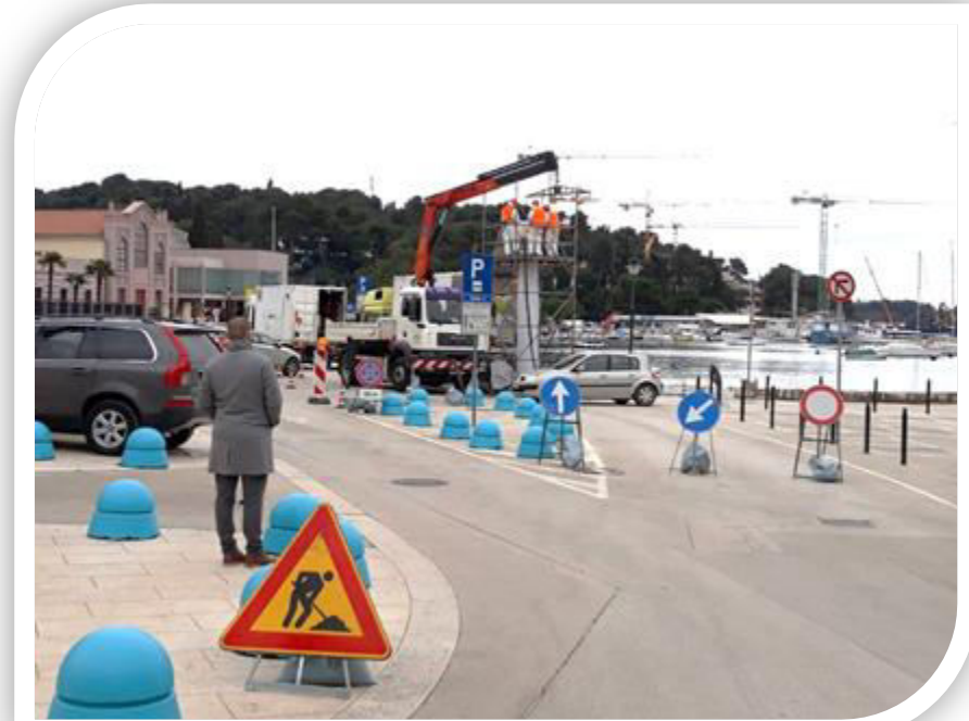
Procedimento di installazione del liner DN800 mm lungo la costa in strada con traffico intenso
