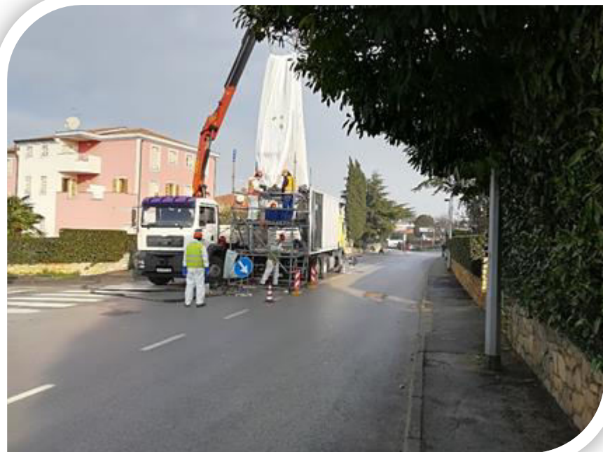
Postupak instaliranja CIPP linera DN1000 mm na prometno opterećenoj ulici, u revizijsko okno dubine 4.5 m
