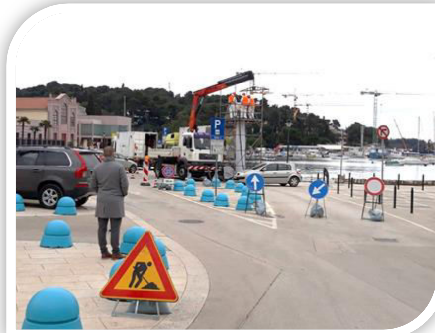
Postupak instaliranja CIPP linera DN800 mm neposredno uz obalu na prometno opterećenoj ulici
